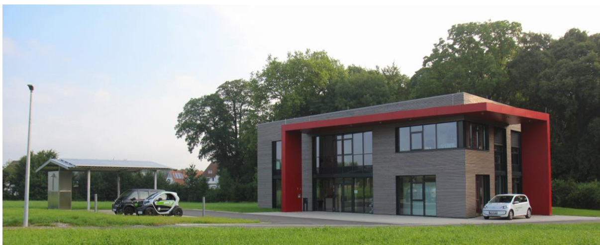
Abbildung 18: Innovationszentrum für Elektromobilität und Erneuerbare Energie im ländlichen Raum
